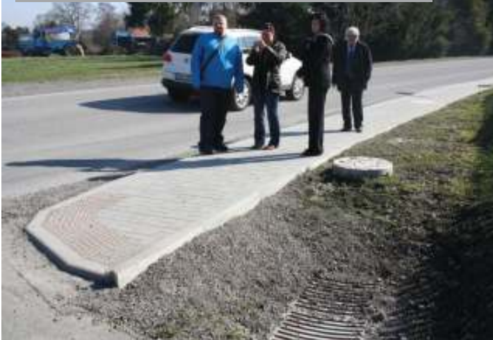
Chodník a zatrubnění silniční příkopy Horní Bludovice (1 252 tis. Kč)
